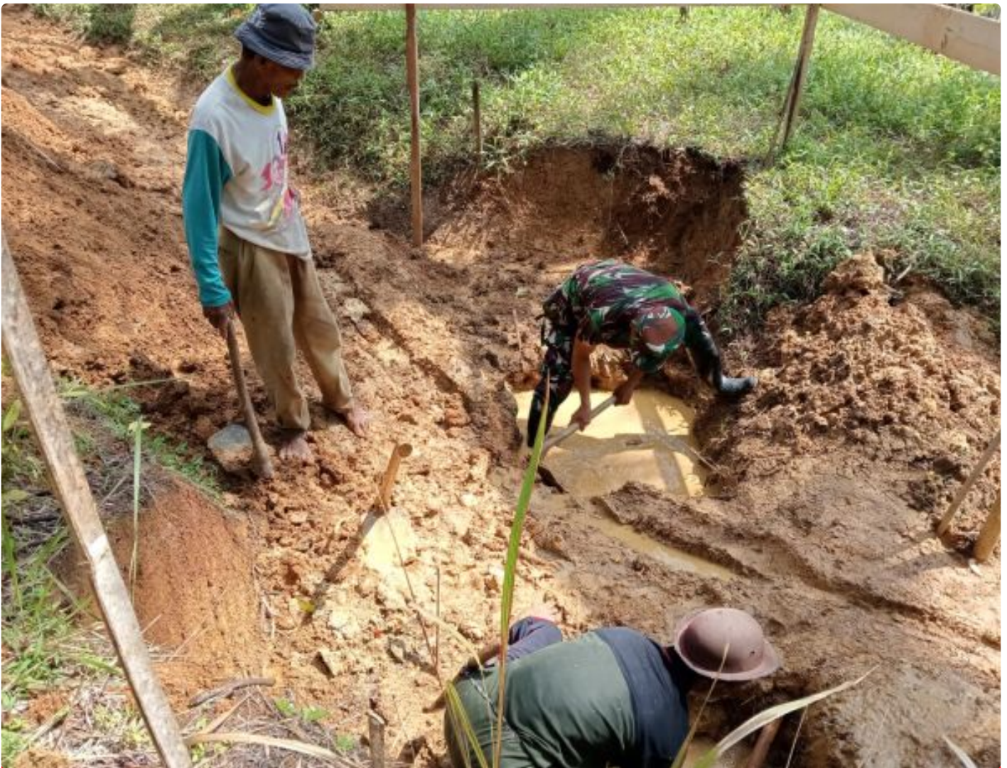
Pembuatan jembatan gantung
